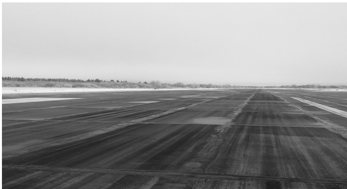
Рисунок 2 – Состояние покрытия после уборки
